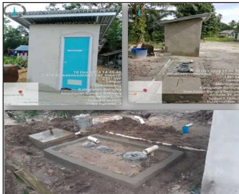
Gambar 3.8. Kegiatan Pembangunan SPALD
