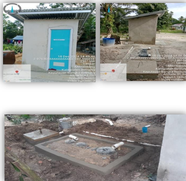
Gambar 2.7.: Kegiatan Pembangunan SPALD Tahun 2024
