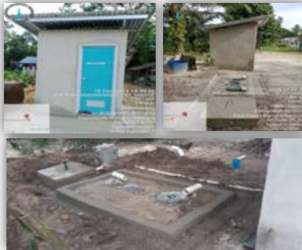
Gambar 3.8.: Kegiatan Pembangunan SPALD Tahun 2024
